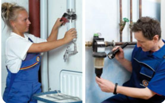
Für die Arbeiten an der Hausinstallation sind die Fachleute der Sanitär- und Heizungsinnung die Profis. rechts: Wasserfilter sind regelmäßig nach DIN 1988-8 zu warten.
